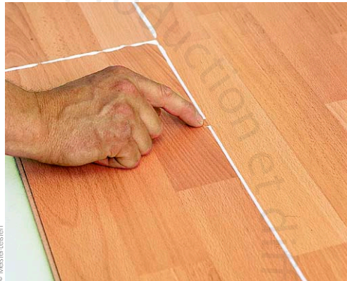
La colle s'échappe des joints lors de la pose, essuyez-la au fur et à mesure.
