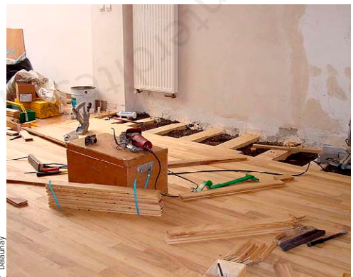
Le plancher est posé dans le sens de la lumière.
