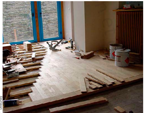
Pose d'un parquet massif sur lambourdes
