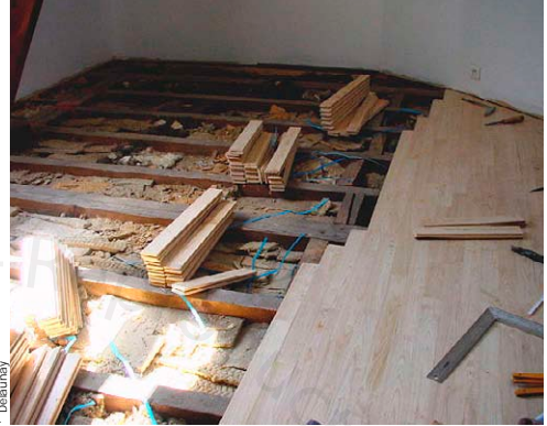
Pose d'un parquet massif sur solives
