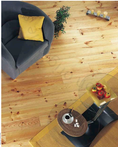
Ce plancher en pin traditionnel a été cloué sur lambourdes.
