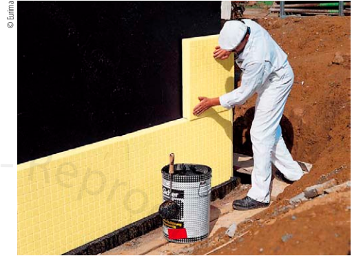
Figure 29 : L'isolation des fondations
